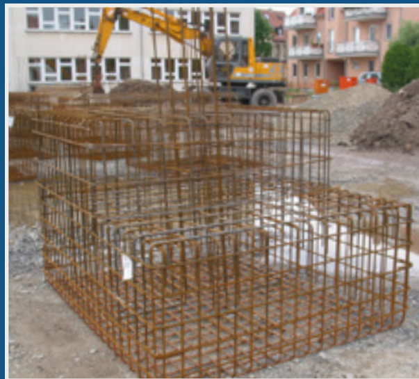
< Bewehrung für Einzelfundamente - auf Wunsch mit vormontiertem Einbauteil >
