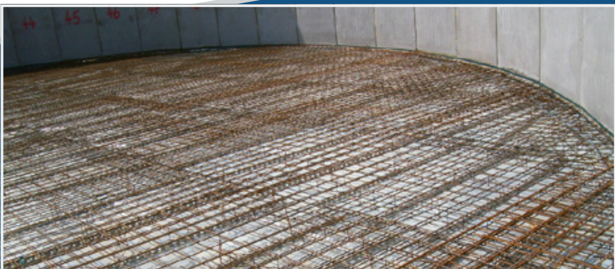
< Bewehrung Bodenplatte im Rundbecken einer Biogasanlage >
