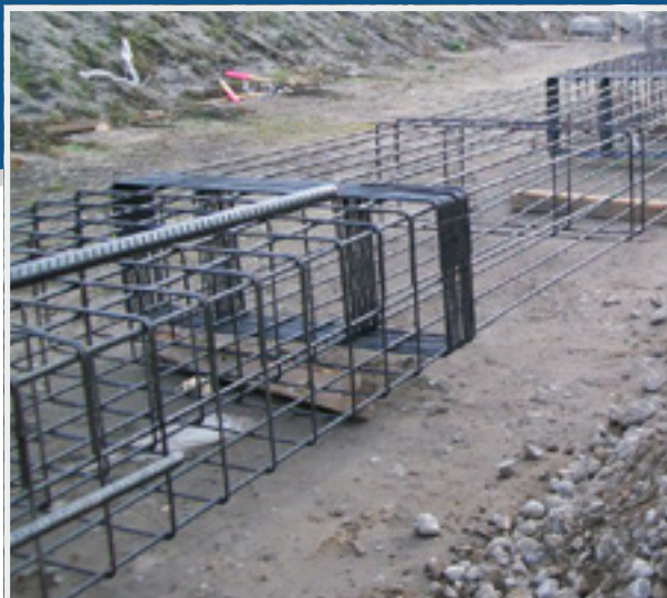
< Bewehrung für Streifenfundamente - Schnelle Endmontage auf der Baustelle durch übersichtliche Dokumentation >
