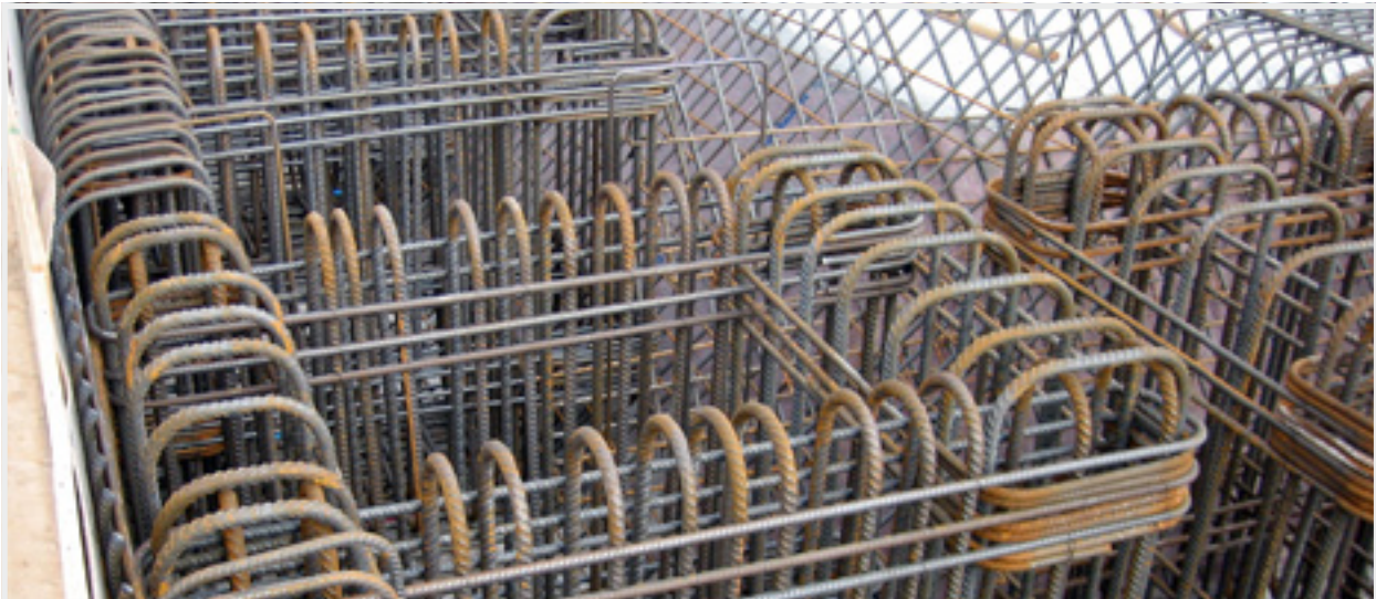
< Bewehrung Schwerlastfundament >
