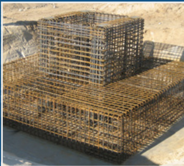
< Bewehrung für Einzelfundamente - auf Wunsch mit vormontiertem Einbauteil >
