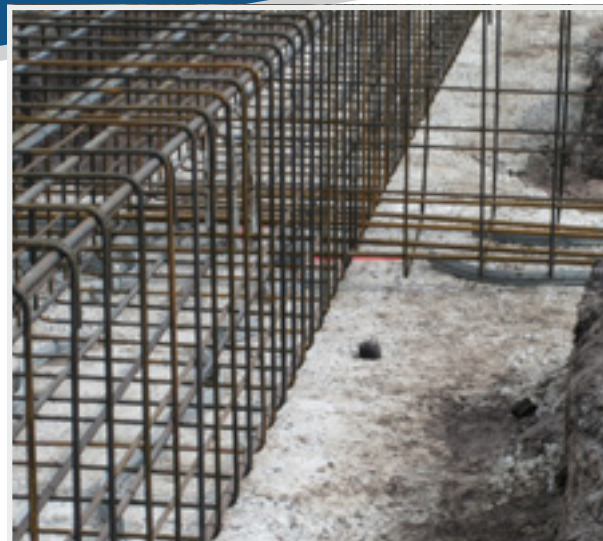
< Bewehrung für Streifenfundamente - Schnelle Endmontage auf der Baustelle durch übersichtliche Dokumentation >
