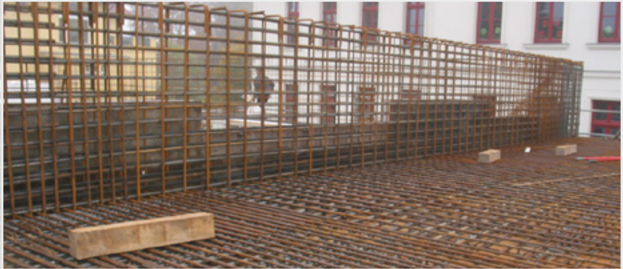
< Bewehrung einer Zwischendecke mit aufgehender Wand >
