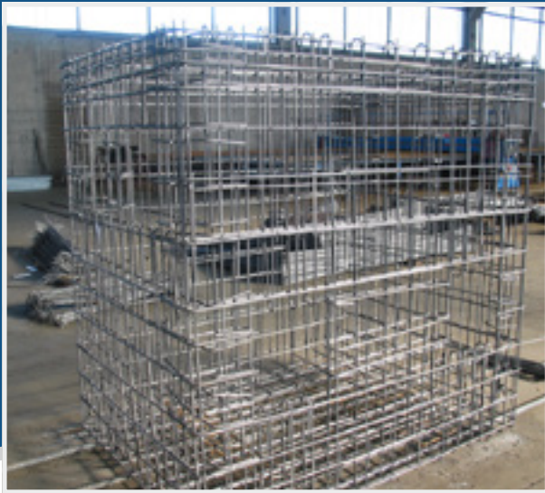
< Bewehrungskörbe für Schachtbauwerke >
