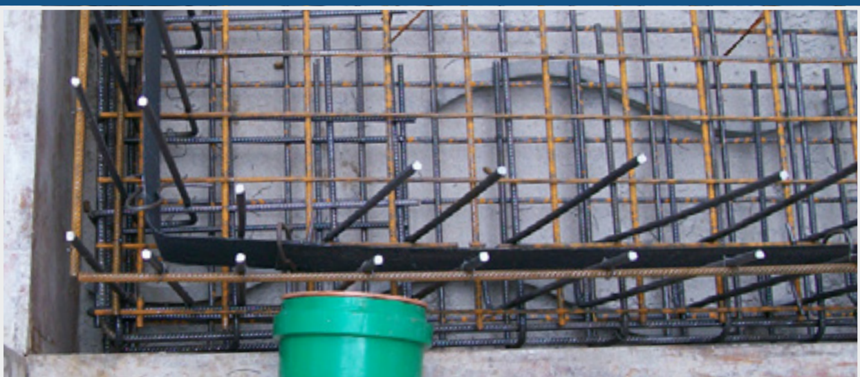
< Abdichtung der Fugen zwischen Kellerboden und zweischaliger Kellerwand mit Fugenblech >
